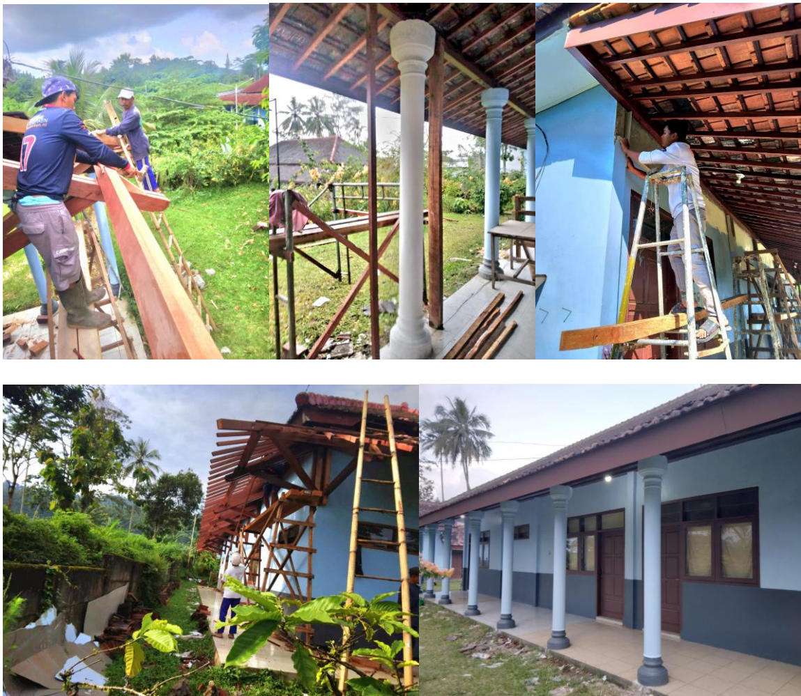
Renovatie van de bijgebouwen
